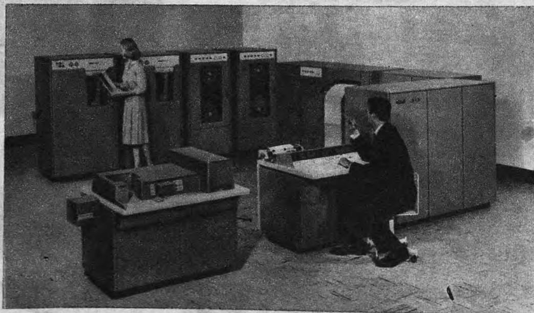
El NCR 315, sistema electrónico de proceso de datos, que permite el acceso en secuencia y aleatorio a la información registrada magnéticamente en unidades CRAM, de las que puede llevar hasta 16 y en las que sólo se ven 2 en la fotografía. Cada cartucho CRAM como el que presenta la señorita, puede almacenar hasta 88 millones de caracteres alfa-numéricos, siendo dichos cartuchos totalmente intercambiables. De la aceptación de este sistema en Europa y América da idea el hecho de que su producción anual de este año había sido vendida ya a finales de 1961
