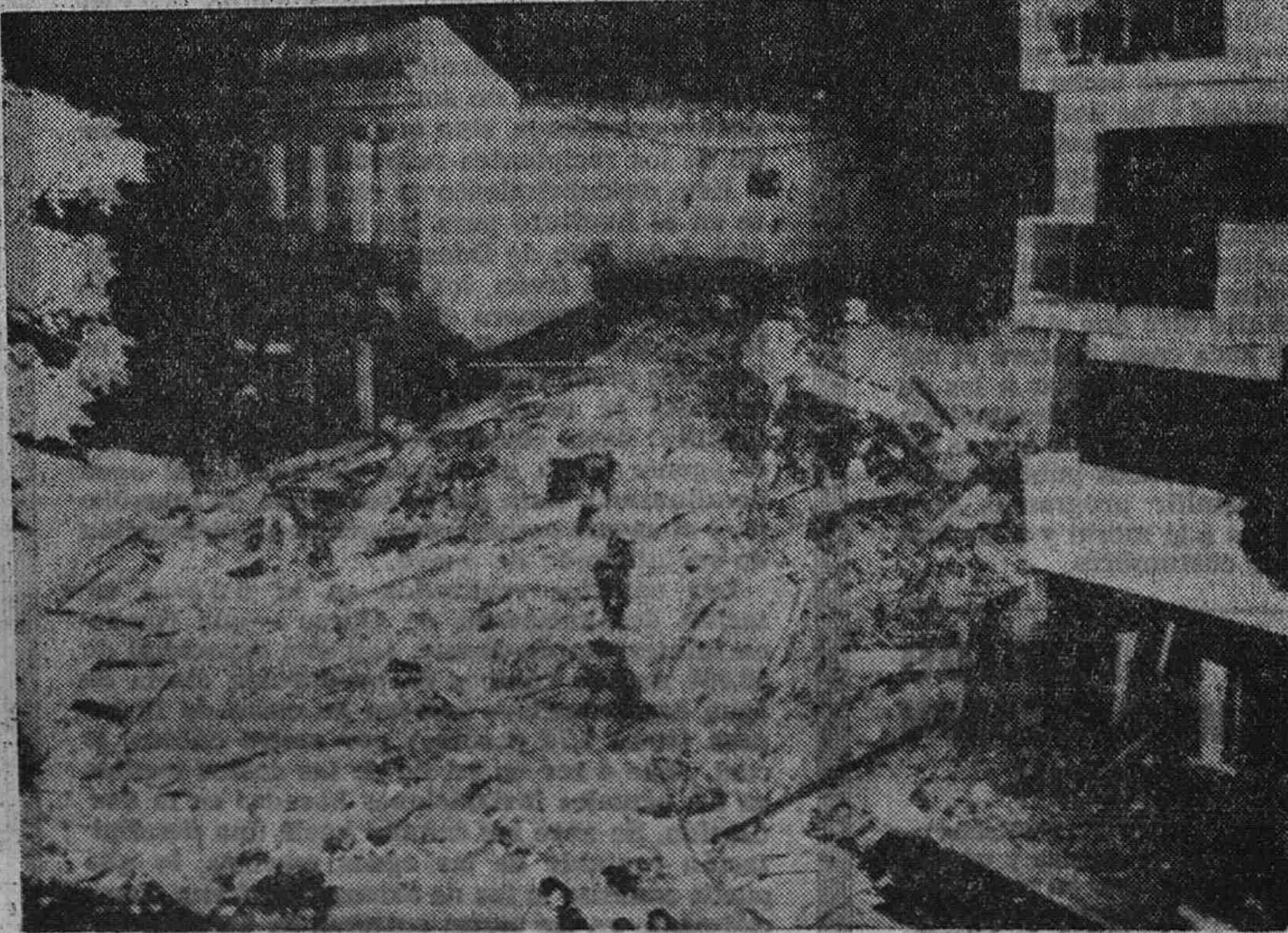
BUENOS AIRES—Miembros de las brigadas de rescate trabajando en la búsqueda de posibles víctimas después del derrumbamiento de un edificio en construcción de catorce pisos. El derrumbamiento sobrevino cuando una piscina instalada en un piso alto perdió toda su agua debido a una rotura. (Upi-Cifra.)
