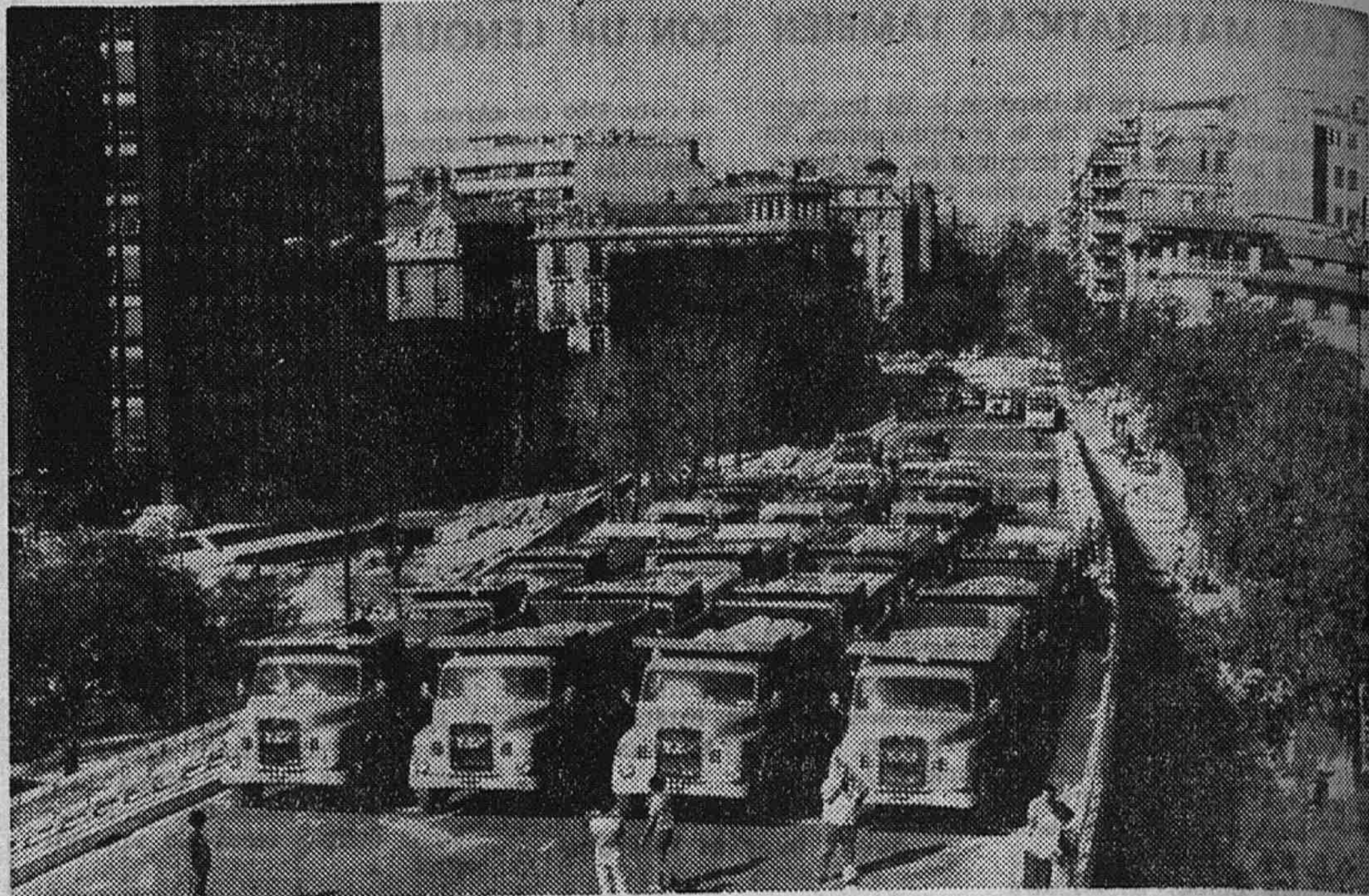
Camiones, con una carga total de 1.000 toneladas, durante uno de los momentos de las pruebas de resistencia a que fue sometido el paso elevado que unir1 las calles de Dato y Serrano. (Foto Cifra.)
