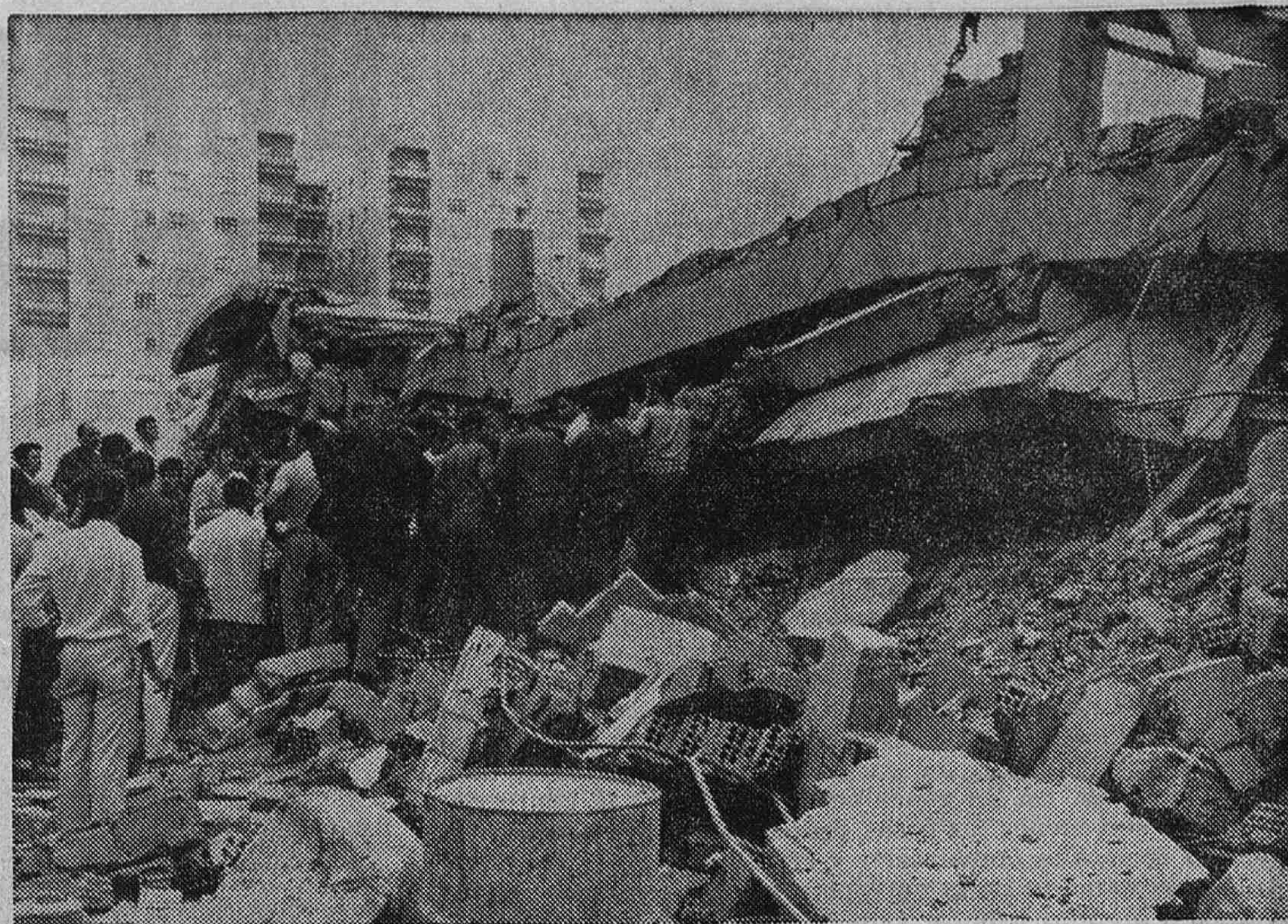
Impresionante montón de escombros al venirse abajo el edificio en construcción, sepultando a los obreros que allí trabajaban
