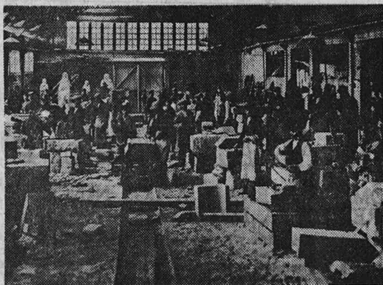
Los canteros tallan los sillares para el edificio de la Telefónica
