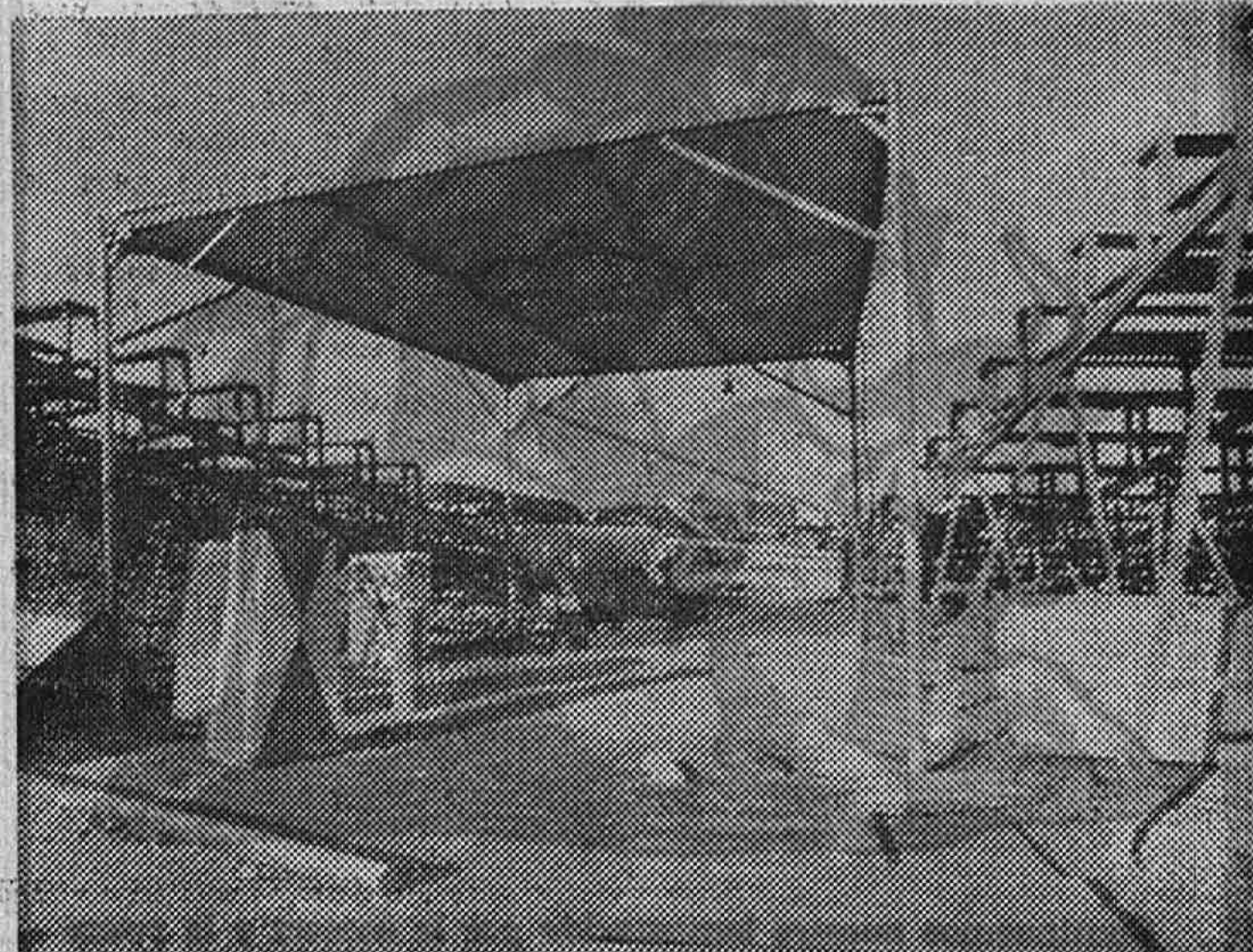
Estado de la pista del Berlin Zirkus. Al fondo se pueden apreciar los mástiles que con su rotura provocaron el hundimiento (Cifra.)
