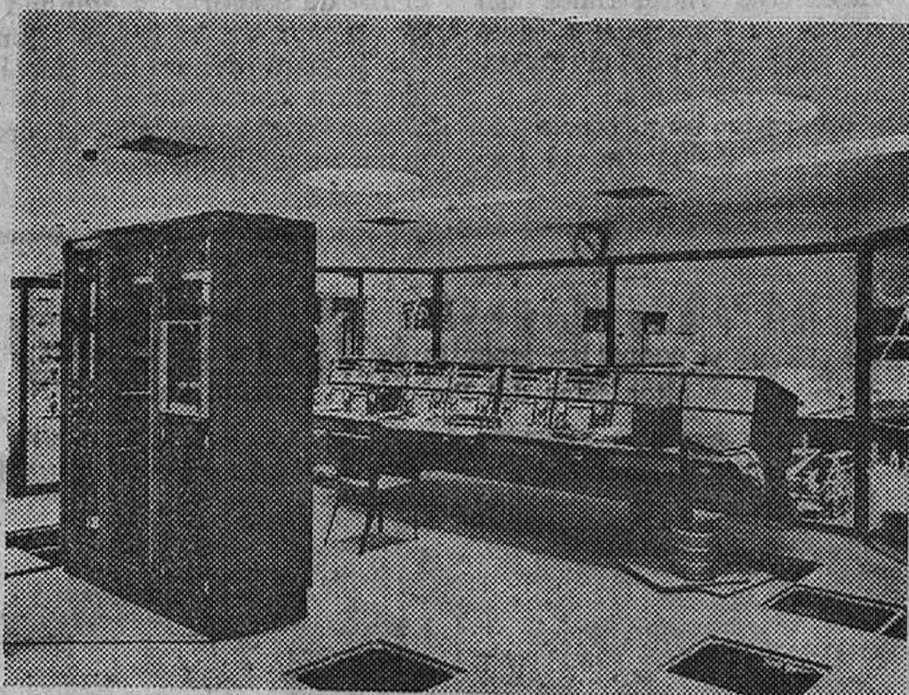
◆ Un aspecto de la mesa de control automático desde el que se ponen en marcha directamente los seis emisores del Centro Emisor de Noblejas
