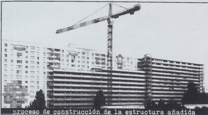
proceso de construcción de la estructura añadida
