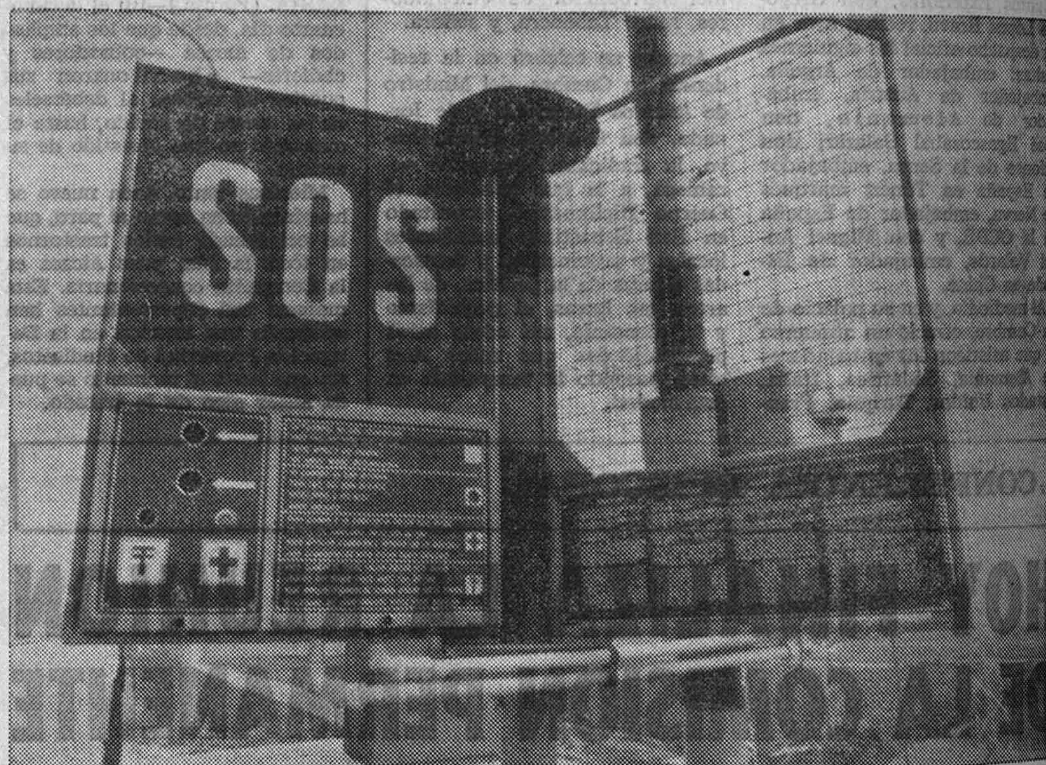
● En cuestión de segundos puede ser recibida nuestra llamada de auxilio y localizado el lugar de la avería o el accidente. En la fotografía, uno de los postes telefónicos que, para asistencia mecánica y sanitaria, hay instalados en algunas carreteras españolas
