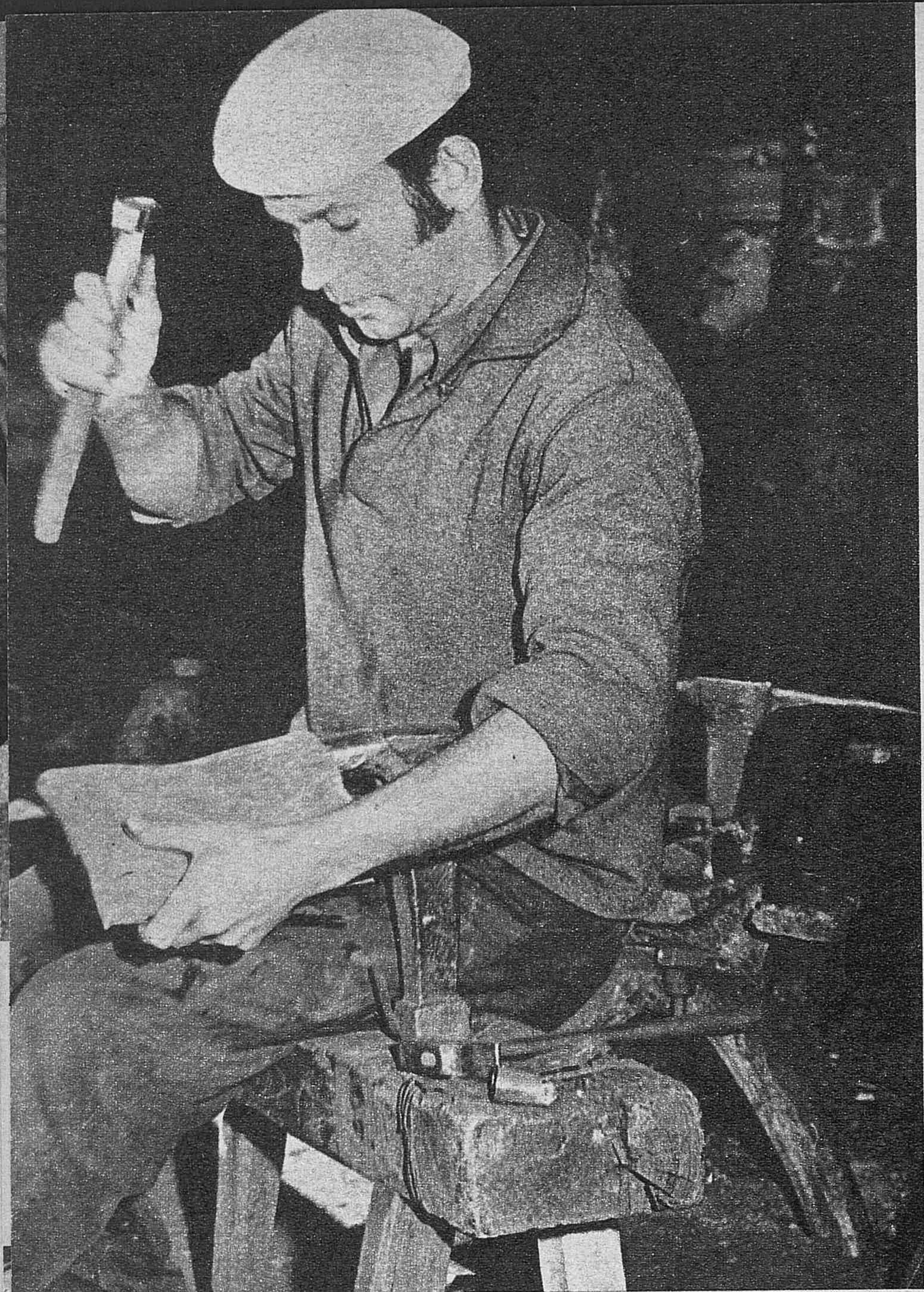
A golpes de martillo, con ayuda de la bigornia, el artesano da forma a la chapa
