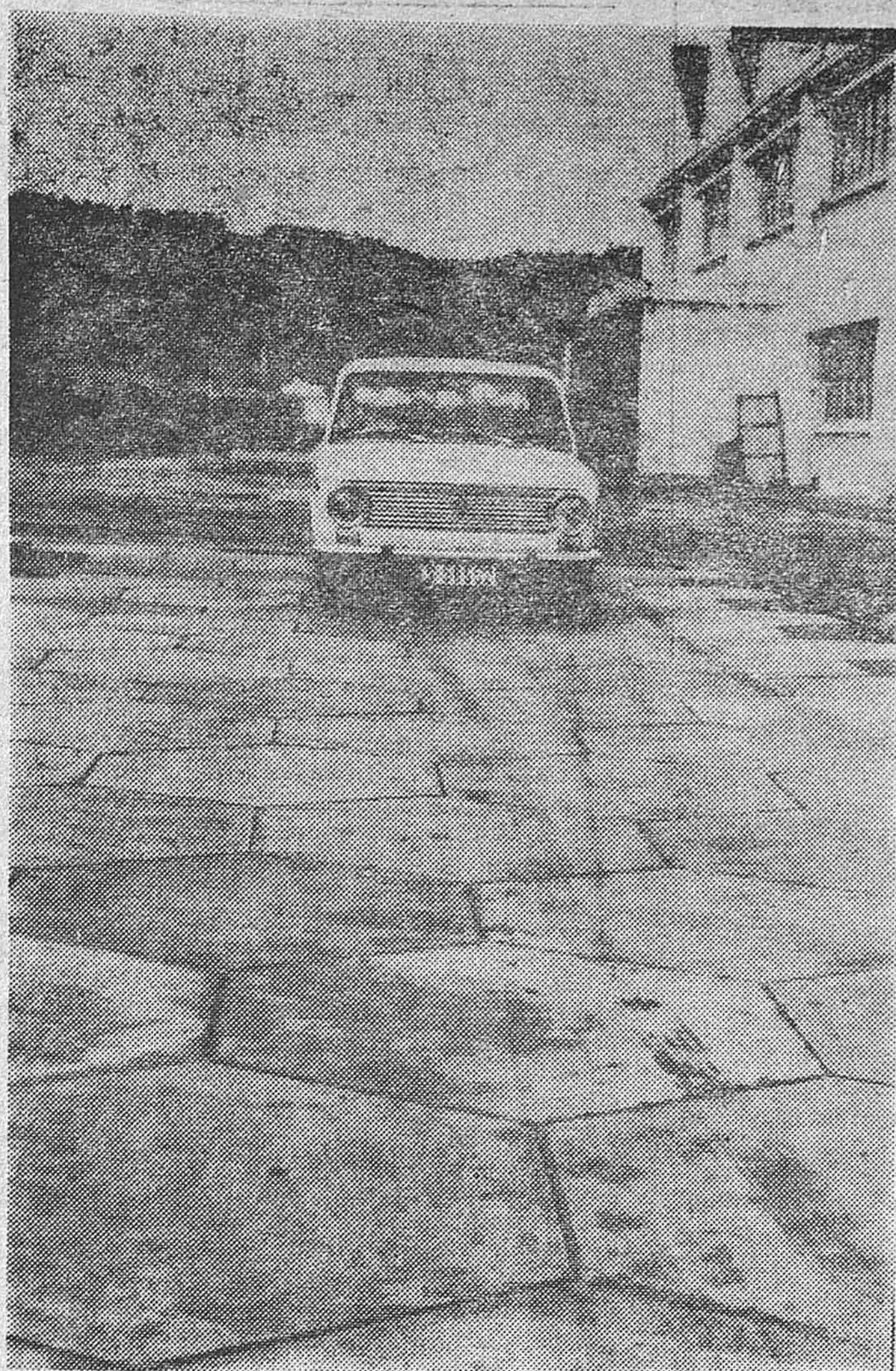
Uno de los inventos que va camino de la «Expo»: Pavimento articulado sin cemento de unión. Fácil de instalar y desmontar. Se acopla al subsuelo y es antideslizante
