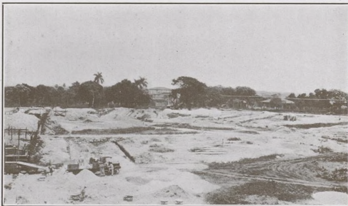
VISTA PARCIAL DE LOS TERRENOS SOBRE LOS CUALES HABIA DE LEVANTARSE EL NUEVO COLEGIO. PRIMEROS TRABAJOS DE CIMENTACION.
