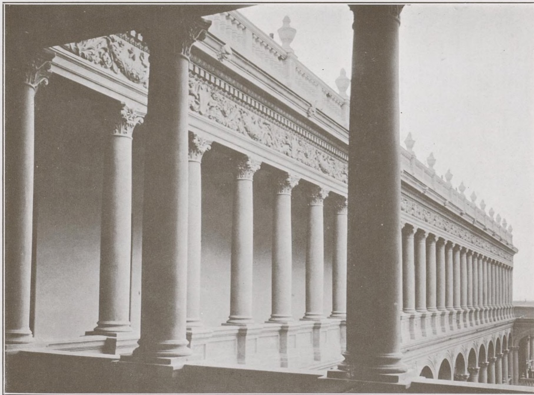
COLUMNATA DE LA GALERIA SUPERIOR DEL ALA IZQUIERDA.
