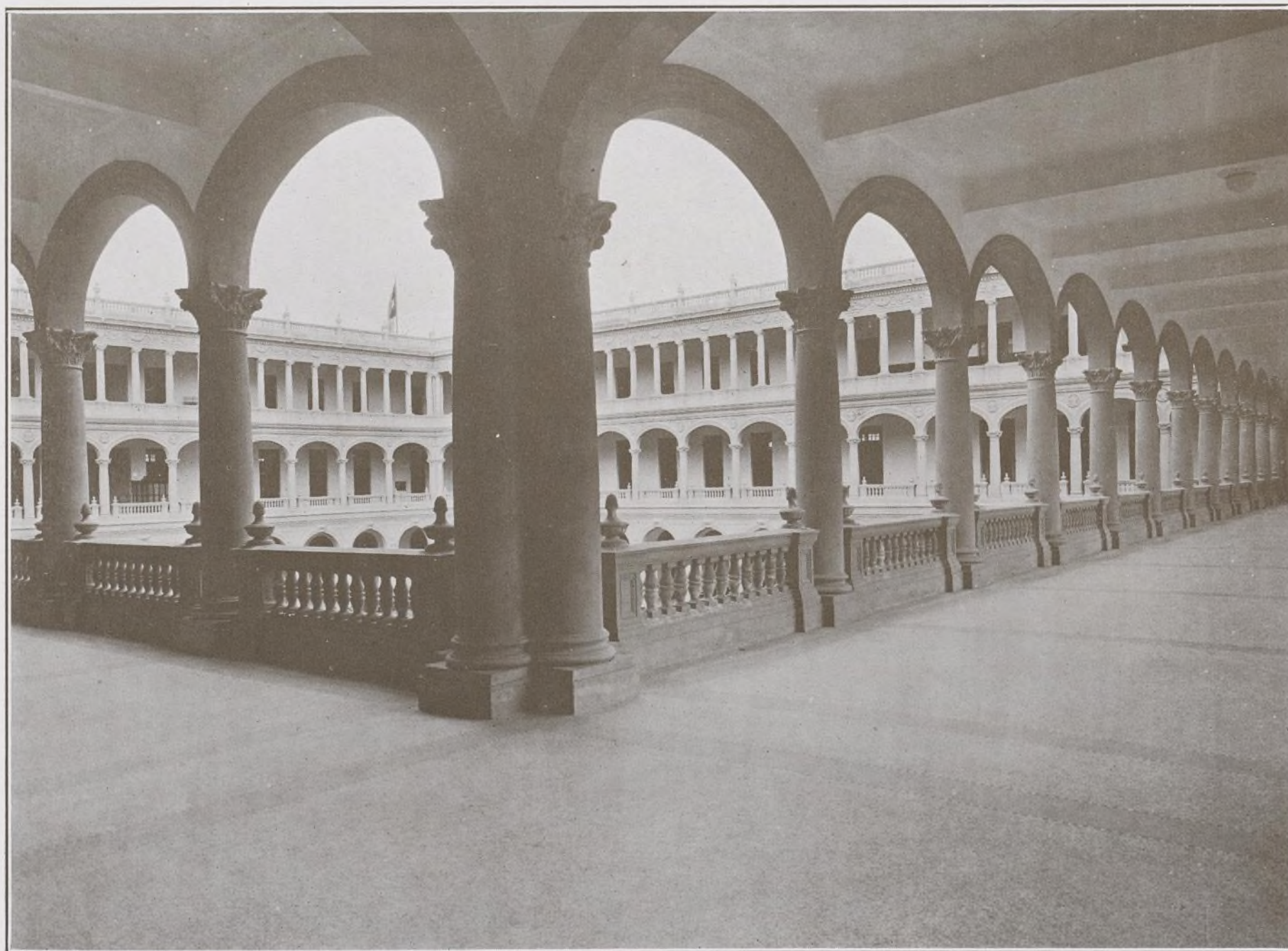
GALERIAS SUPERIORES, QUE DAN AL PATIO DEL SAGRADO CORAZON. (HAY OTRAS IGUALES EN EL PATIO DE LA DERECHA)
