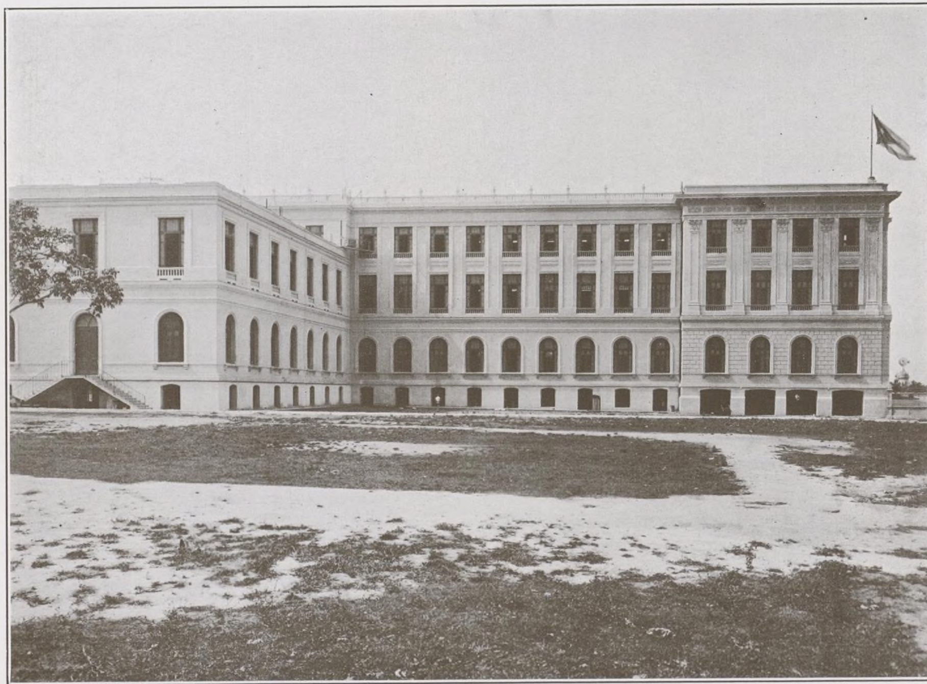
ALA IZQUIERDA.—HAY OTRA IGUAL EN LA DERECHA Y MIDE CADA UNA 41 METROS DE LARGO POR 8\frac{1}{2} DE ANCHO. LAS DOS TIENEN SOTANOS Y TRES PLANTAS.
