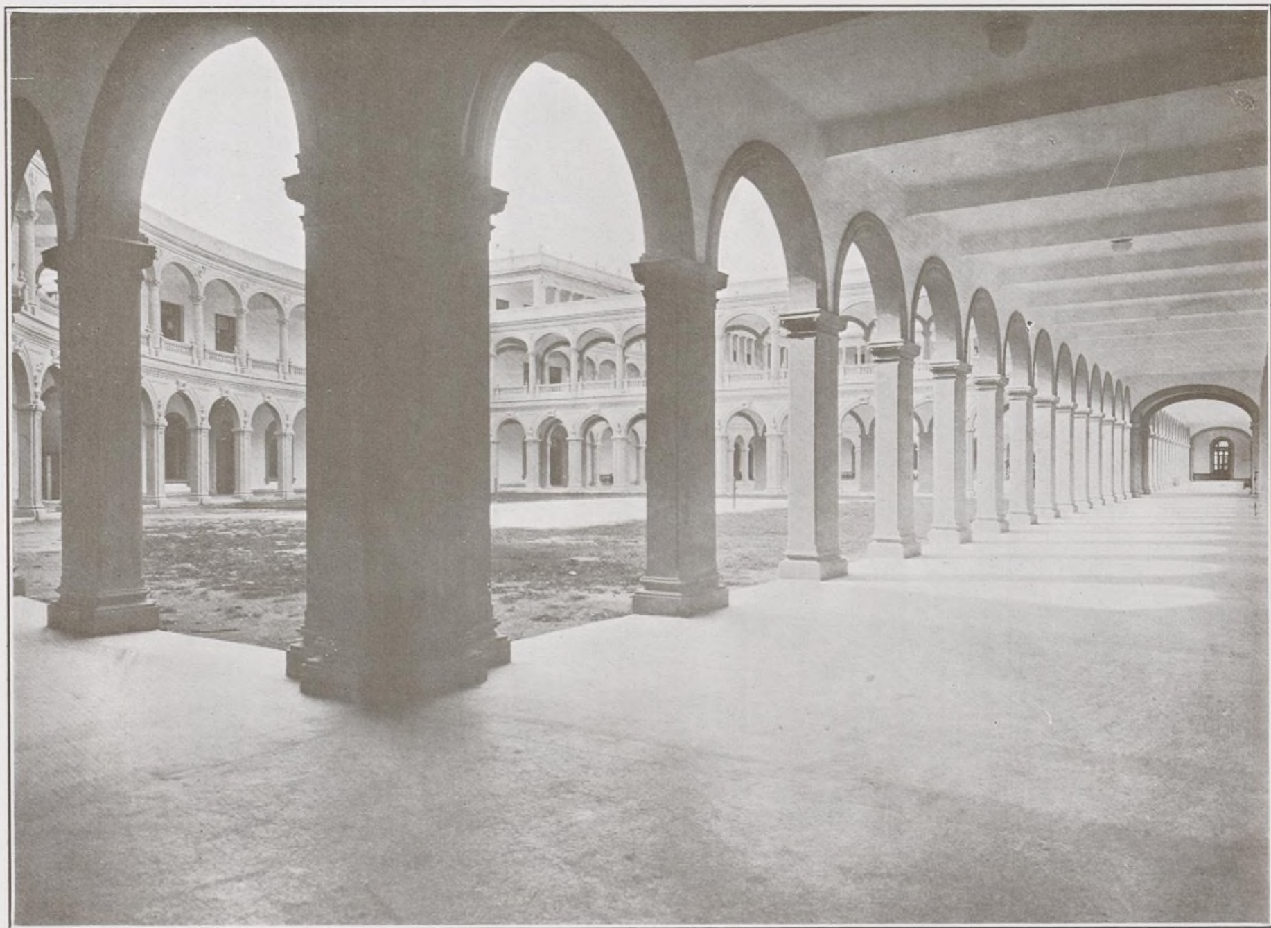
GALERIA QUE UNE LOS PABELLONES 1 Y 9. (MIDE 140 METROS LINEALES).
