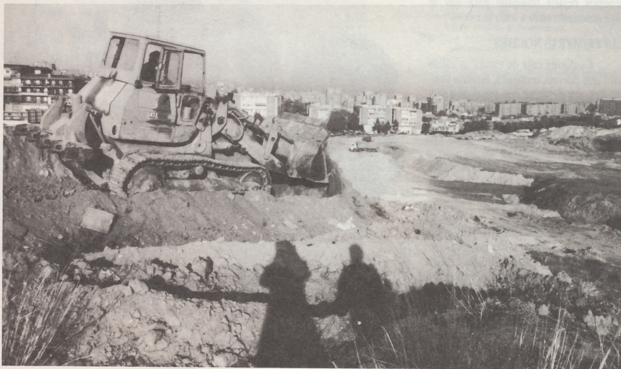
Septiembre 1990: inicio de obras.
