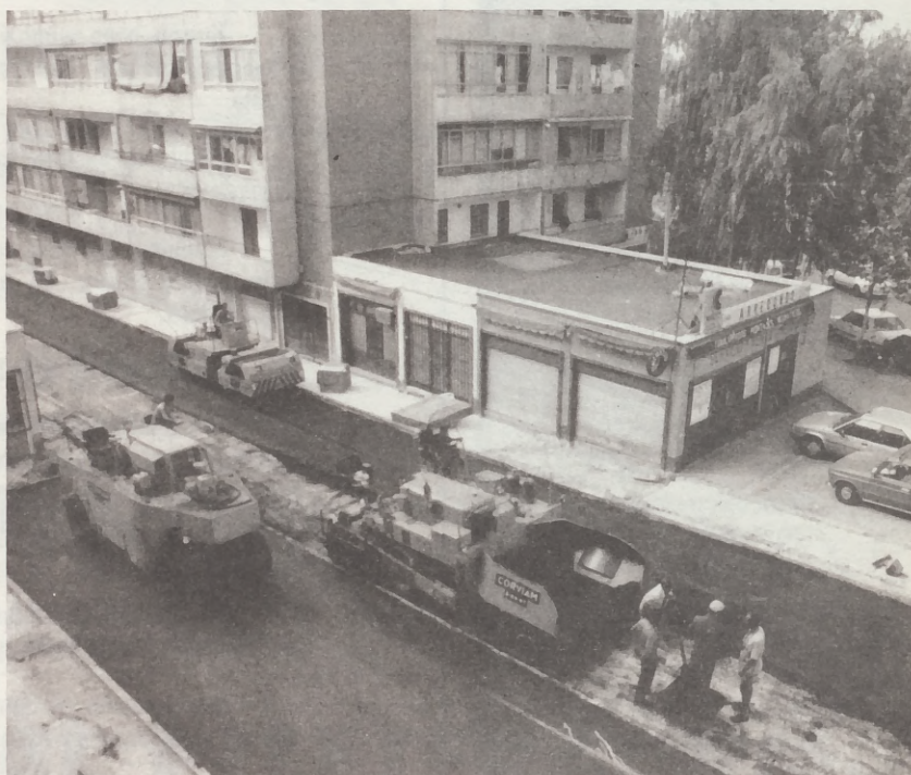
Barrio de Villaamil: Nuestro Barrio mejora su imagen, nuevo asfalto, aceras e iluminación más efectiva.
