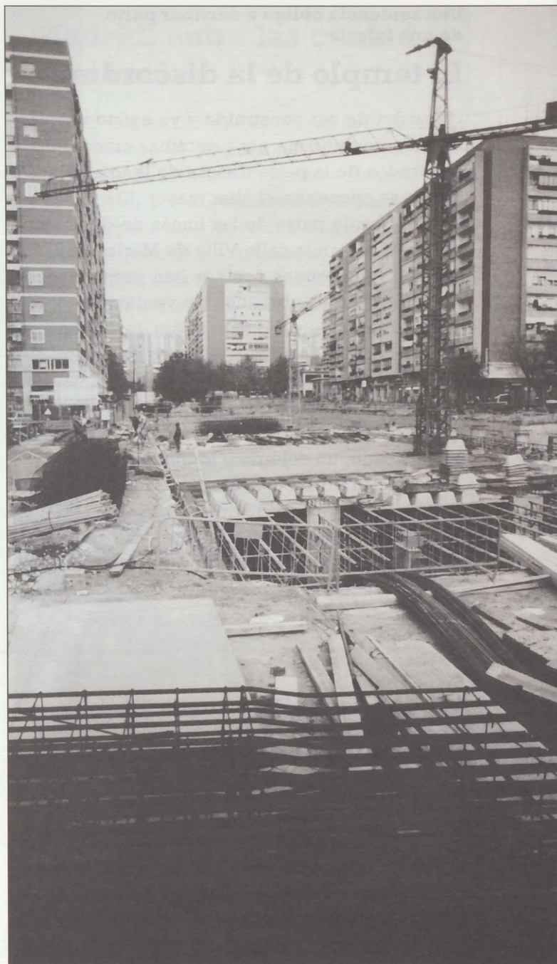
Aspecto de las obras del parking de Sarriá
