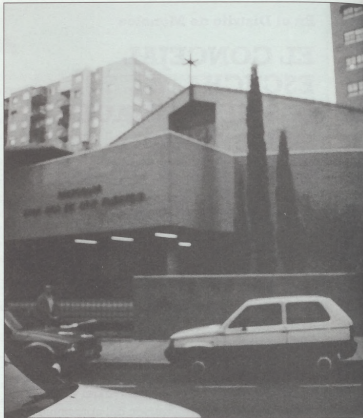
La sentencia obliga a derribar parte del altar mayor
