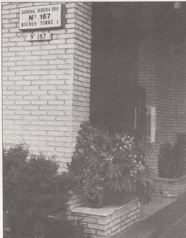
Portal donde se desplomó un ascensor el pasado mes de noviembre
