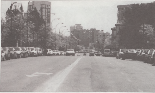
El tercer tramo, entre la glorieta de Francos Rodríguez con Pablo Iglesias y Ofelia Nieto y el parque de Dehesa de la Villa, es el más ancho de toda la calle.
