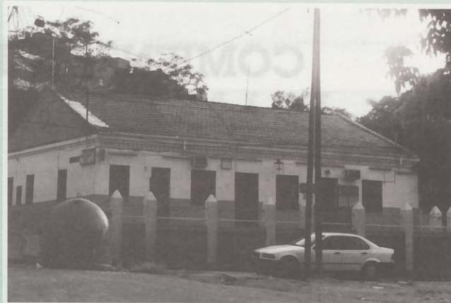
Este edificio albergó en su día el bar Villa Lidia, auténtico eje de la diversión de los vecinos de la zona.
