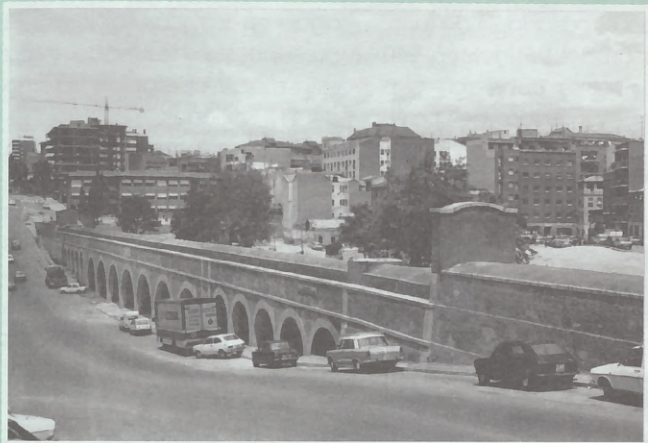
El Puente Amaniell o acueducto del canalillo y su entorno enlazan los barrios de Bellas Vistas y Ciudad Universitaria. Formando parte del actual paseo de Pablo Iglesias.
