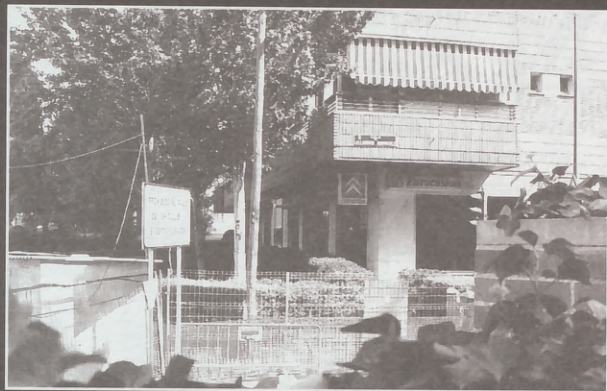
Continúan las obras de la boca del Metro en la calle de Alejandro Rodríguez.
