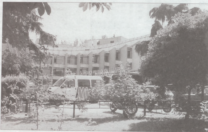
Aspecto exterior de la actual sede de la recién segmentada Clínica Puerta de Hierro.
