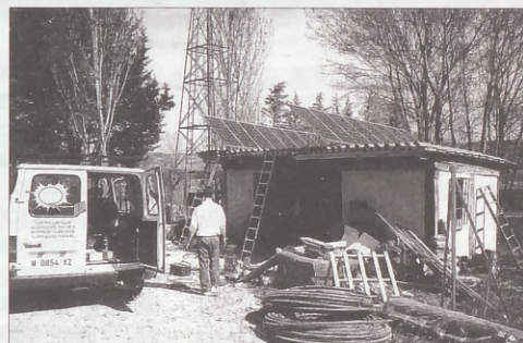
Trabajos de electrificación en instalación fotovoltaica para producción de electricidad (Guadarrama)
