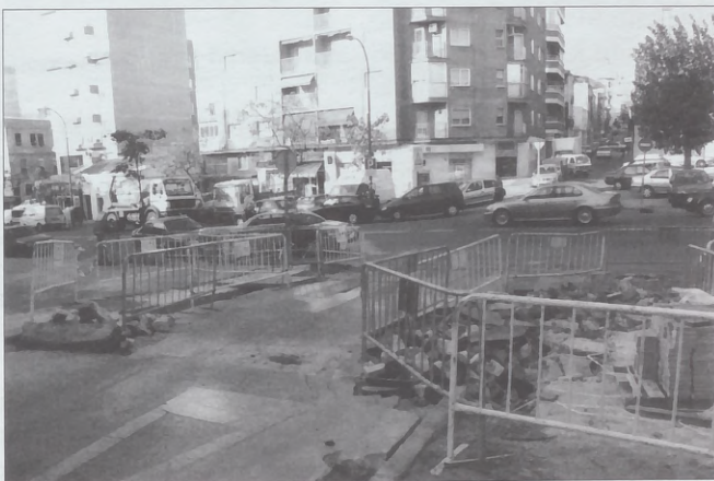
Este es el aspecto de muchas calles de Tetuán. Las obras permanecen durante semanas, con gran perjuicio para los vecinos
