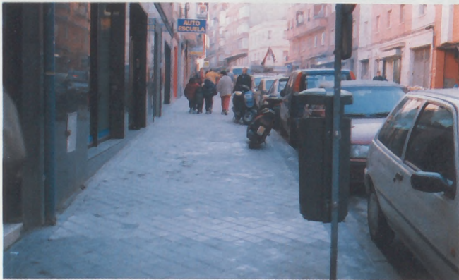
Otra de aceras. En la imagen superior una muy estrecha y abajo otra excesivamente ancha en relación con las posibilidades de la calle
