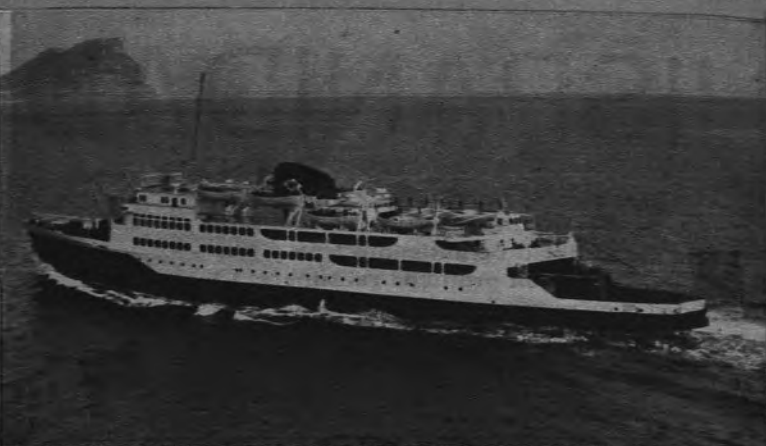
Buque trasbordador "VICTORIA", gemelo del "VIRGEN DE AFRI-CA", de 1.200 Tons. de P. M. y 3.310 de R. B., con dos motores propulsores, con un total de 5.300 BHP. Construido por encargo de la Empresa Nacional ELCANO, para la Marina mercante española
