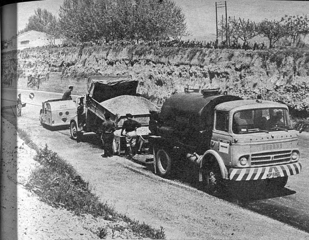
RIEGO SUPERFICIAL. — Camión regador, extendedor de gravilla y apisonado final
