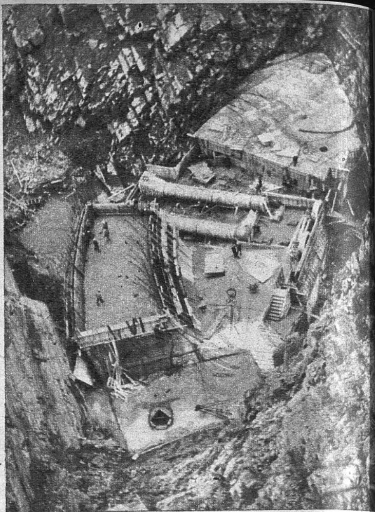
Obra de hormigonado de la presa de Santa Eulalia
