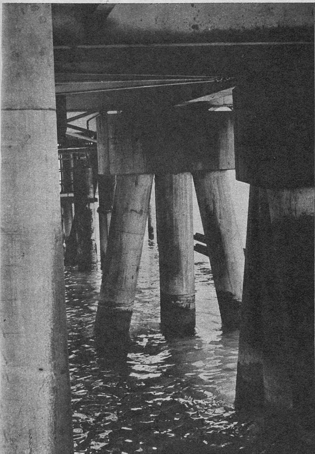
Pilotes de cemento que sujetan las plataformas al fondo. A la derecha, un bosque de torres perforadoras cubre las aguas del Maracaibo
