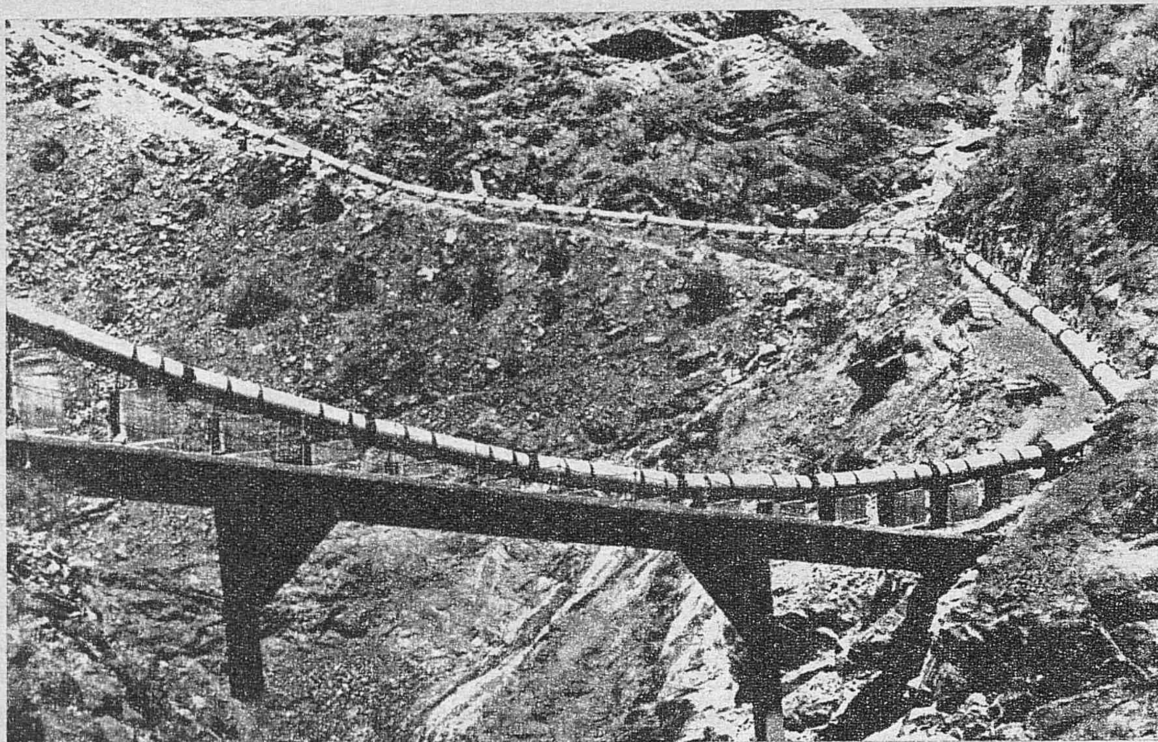
Tubería presión con unión Gibault. Sifón en TIFARACA
