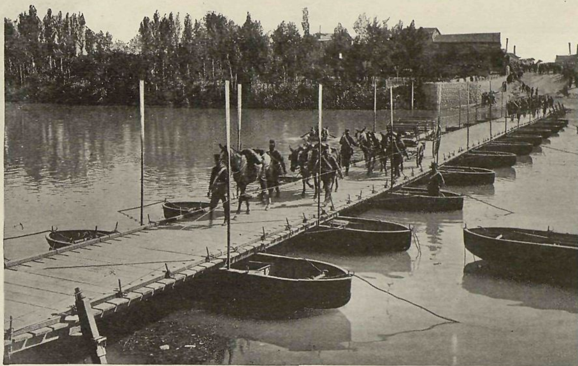
Tendido rápido de un puente sobre pontones durante maniobras
