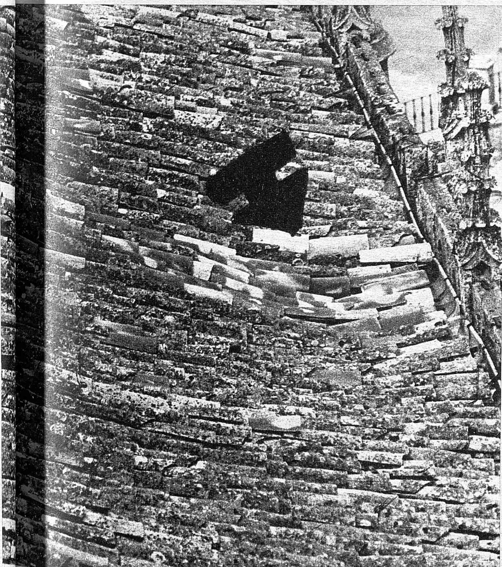
Rechumbre de la capilla de Santa Tecla, en la que se aprecia el derrumbe
