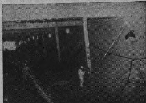
En los muros laterales se ha cambiado la sección típica rectangular por una trapezoidal, que duplica el volumen de aire y disminuirá el trabajo de los equipos de ventilación.
