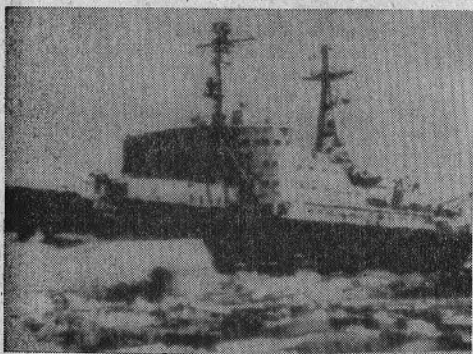
■ N. E. B. H. H., URSS. Rómpehielos, 44.100 S. H. P. Desplazamiento (plena carga), 16.000 toneladas
