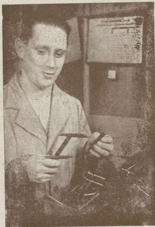
Obrero ciego comprobando el largo de unos tubos por medio de una regla movable en la Casa Zeiss-Ikon.
