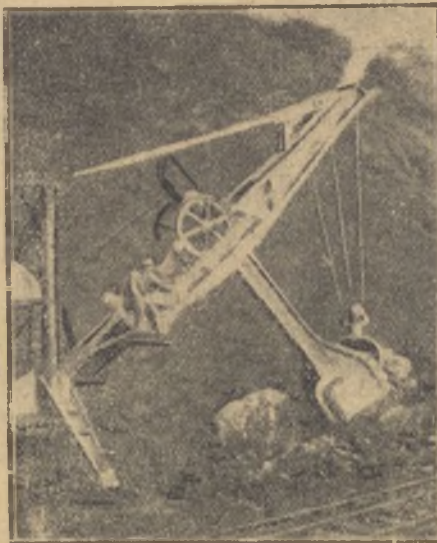
Los titanes de la mecánica. Una excavadora monstruo, movida á vapor, trabajando en las canteras.
