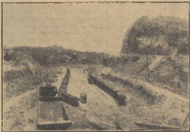
Un barreno gigantesco. 9.600 libras de pólvora negra á las que se hizo estallar en cuatro agujeros de 78 pies de profundidad.
