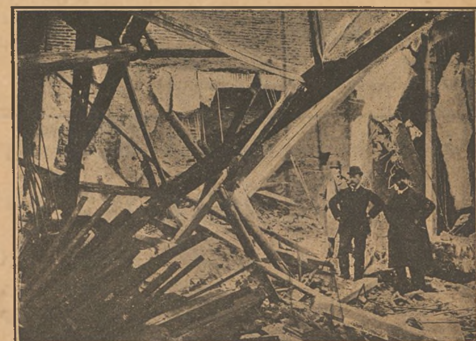
Los ingenieros reconociendo los destrozos hechos por el derrumbamiento del muro en un piso de hormigón armado, sistema Ribera.—(Fot. de H. Jalco.)
