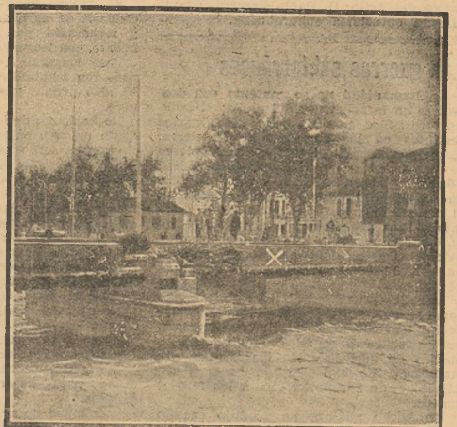
(X) Enorme boquete abierto por el formidable empuje de las aguas en el puente Duque de Tetuán. El río, en este sitio rebasó la altura del puente, desbordándose. (Fot. Hall).
