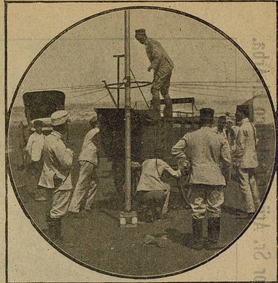
Ingenieros de la telegrafía sin hilos, montando una estación móvil que utiliza la columna de operaciones.
