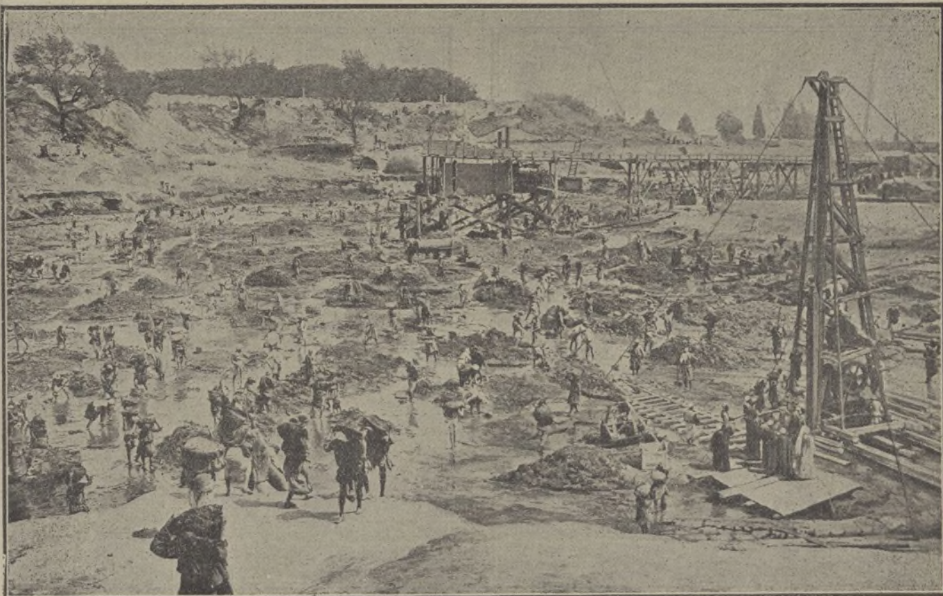
Reconstrucción del dique y presa del Cairo para retener y distribuir las aguas del Nilo. Es un trabajo colosal de ingeniería moderna, dirigido por los ingleses, y en el que se ocupa un verdadero ejército de obreros, más de cuatro mil hombres. Esta fotografía es una perspectiva general, que revela la distribución detallada de tan gigantesco esfuerzo.
